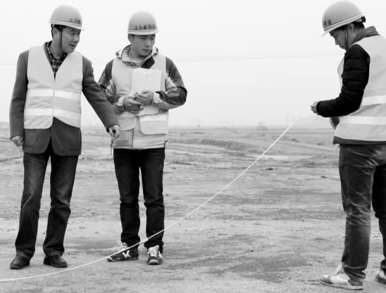
王光明(左一)在施工现场抽查路基宽度。朱园园 摄
