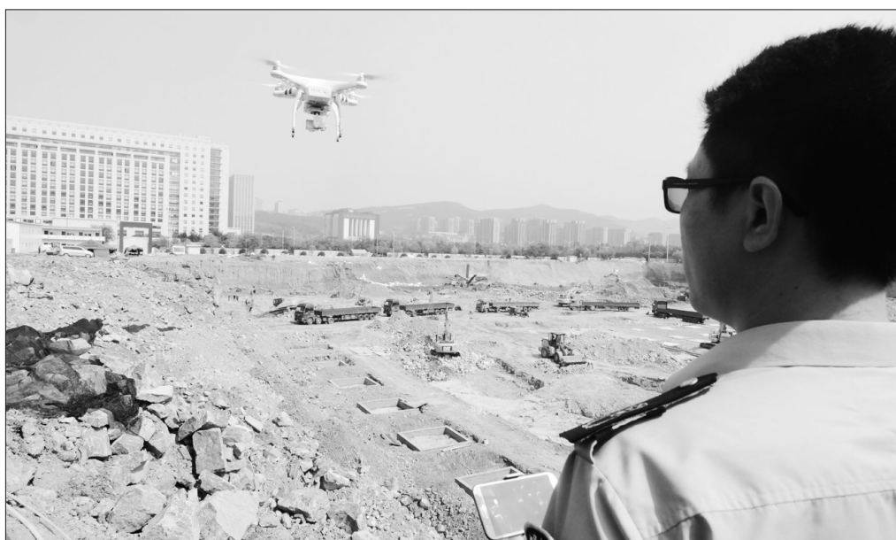
济南市启用环境执法无人机,全面提升建筑施工工地的监管水平。 图为执法人员操控无人机对施工现场进行环境监测。 环环宣供
