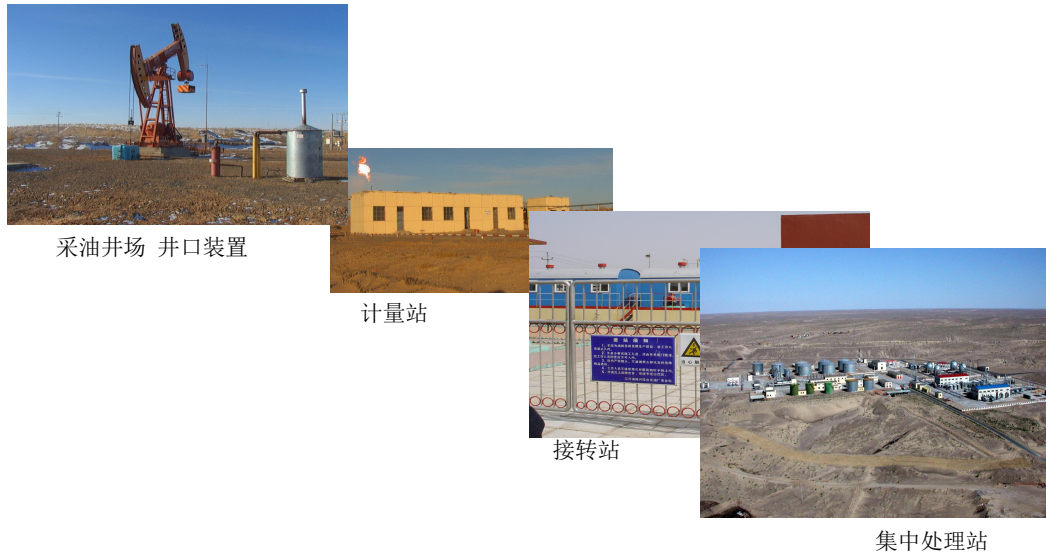
图 5-1 油气田主要地面工程设施
