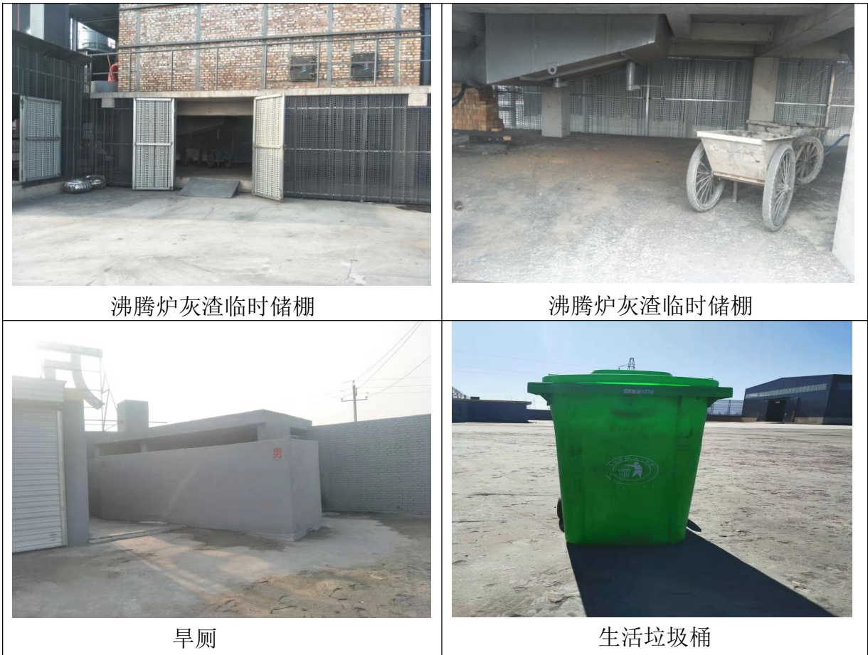
图 3-1 固废污染防治设施现场照片
