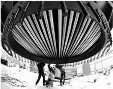
连云港碱业有限公司日前对1号碳化塔进行整体更新技改,该项目更新技改后产能将提升15%~20%。据悉,该公司今年投入2000万元资金,对超负荷运行的陈旧设备进行更新改造和设备维护,以降低能耗,消除运行安全隐患。朱华南 摄
