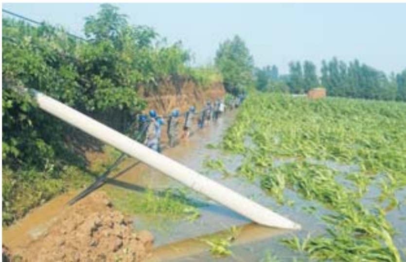
△国网山东惠民县供电公司快速修复因飓风受损的线路
