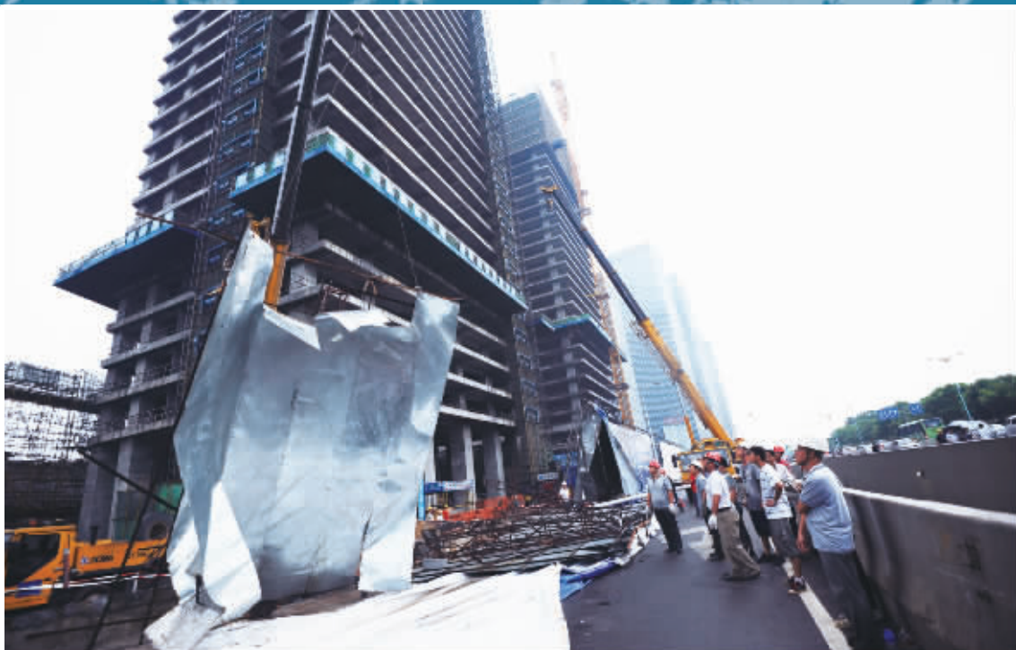
8月19日，长沙市湘江路，一广告牌在狂风暴雨中突然倒塌，并且砸倒了路边的路灯。 记者 童迪 摄
