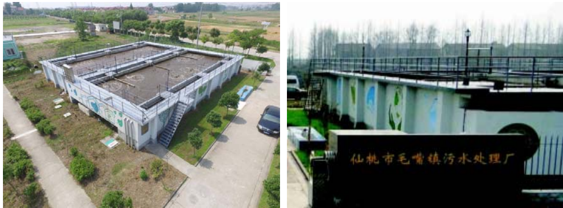
图 8 仙桃市毛嘴镇污水处理厂厂区图
