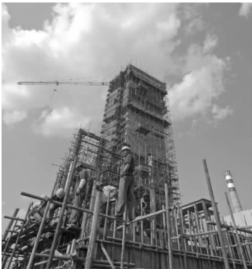
施工中的熄焦塔
