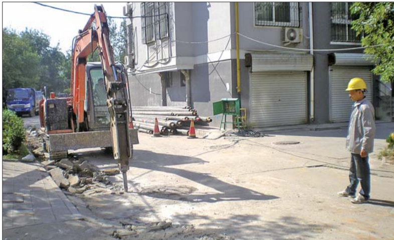
施工人员准备整修暖气管道。见习记者 刘树升 摄
