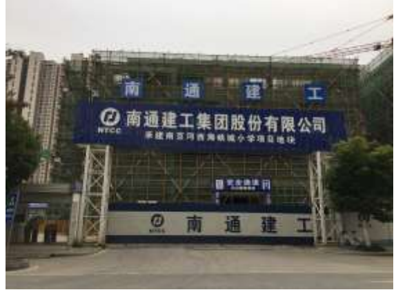
管道沿线在建小学
