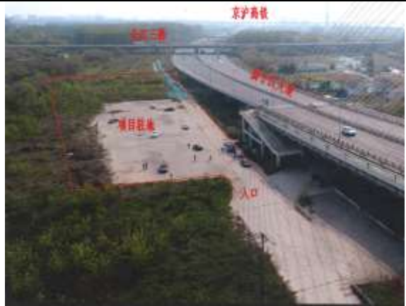
施工营地选址
