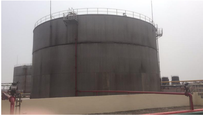
图1 1#储罐现状照片
