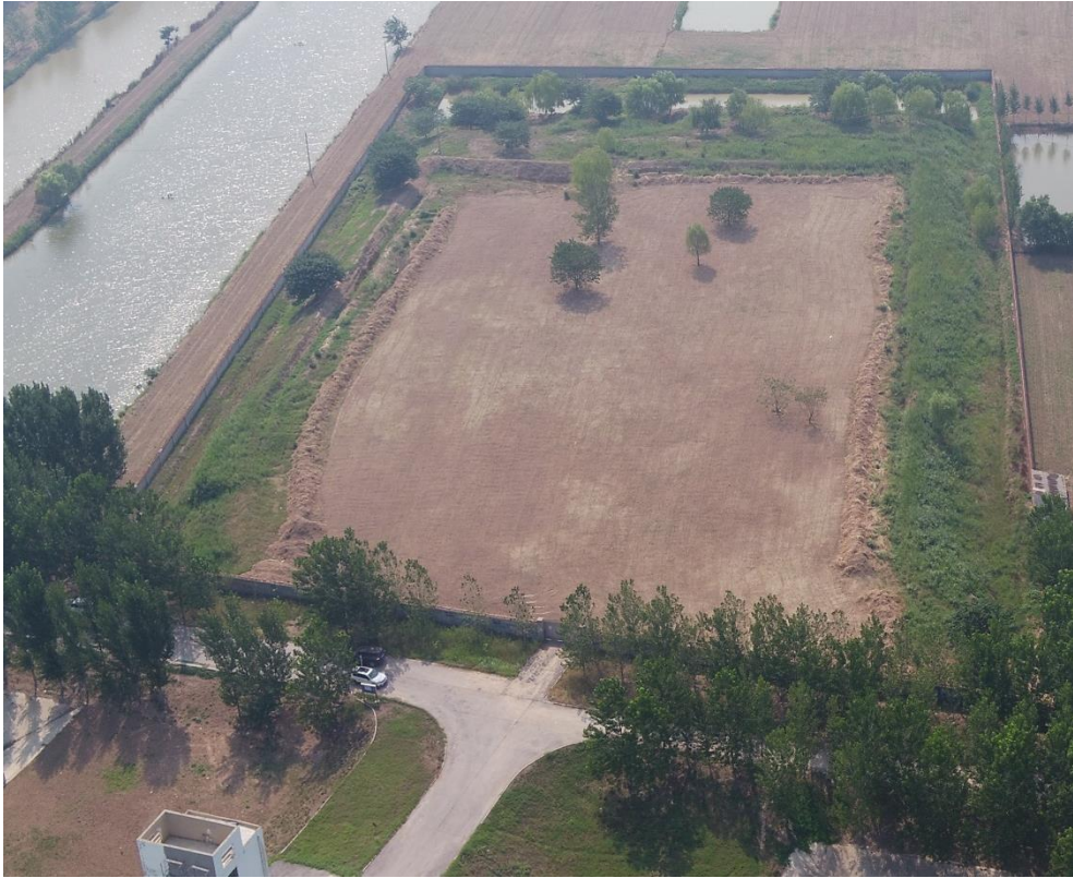
图 3.2-1 大沙河闸弃土场现状
