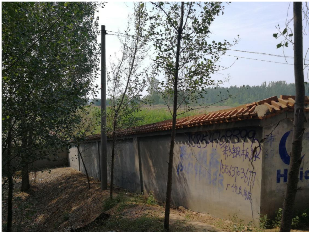
图 3.2-2 大沙河闸取土场现状
