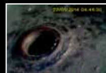
使用6mm长焦镜头 (VSA2-1) 检查储罐孔洞
