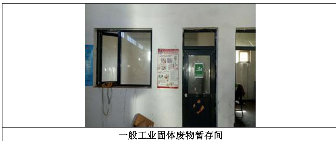
图 4-1 固废治理设施照片
