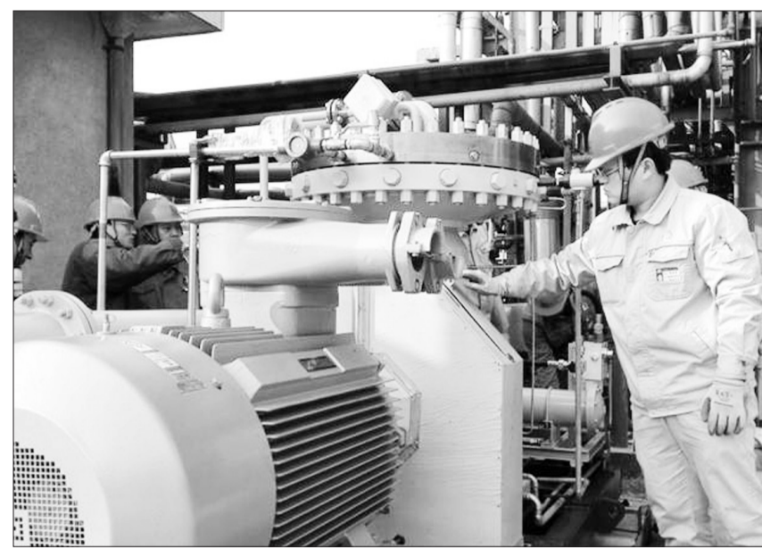
山东省淄博市齐鲁石化塑料厂高压装置排放气回收压缩机日前运抵装置现场。这个设备是排放气回收项目中的核心设备,项目改造完成后,可实现对低压泄漏气中乙炔气的回收,减少有机气体燃烧带来的二氧化碳排放。王敬华摄
