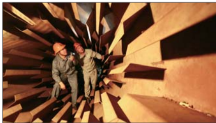
▲检修脱硫装置。 顾波 摄
