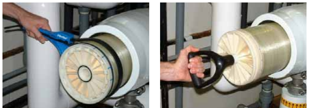
图 2. 用于端面自锁膜元件安装的轻型带钳（左）和拉手（右）
