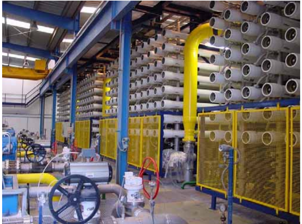
西班牙 Lanzarote 岛 (Inalsa) 使用 FILMTEC 反渗透膜元件将海水淡化成饮用水。选用了 iLEC 端面自锁连接膜元件使整个过程更简单并节省了费用 (图片由 Inalsa 友情提供)。
