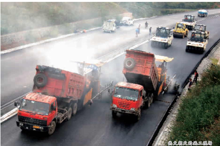
热火朝天的施工现场
