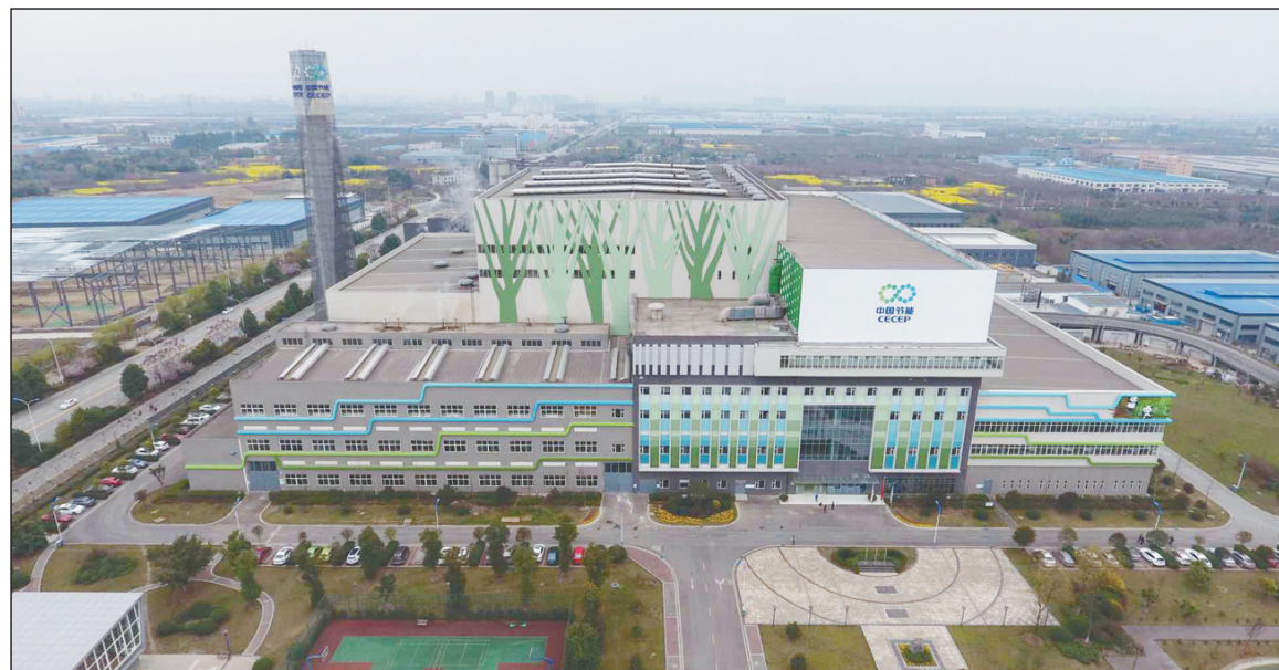
图为成都祥福生活垃圾焚烧发电项目全景。 中节能供图
