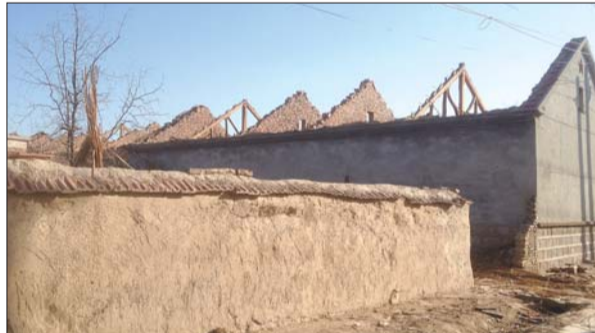
正在拆除的西刘木村。
