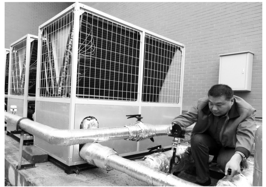
北京市持续推进能源结构调整。在燃气管线难以到达的区域,各区因地制宜,采用压缩天然气、液化天然气、电蓄热锅炉、热泵等多种改造形式全力完成清洁能源改造任务。图为北京林业大学安装了一套低温空气源热泵系统,开创区域供暖新模式。
