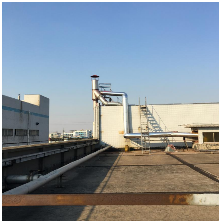
图 4-3 废气排气筒 Q5 图
