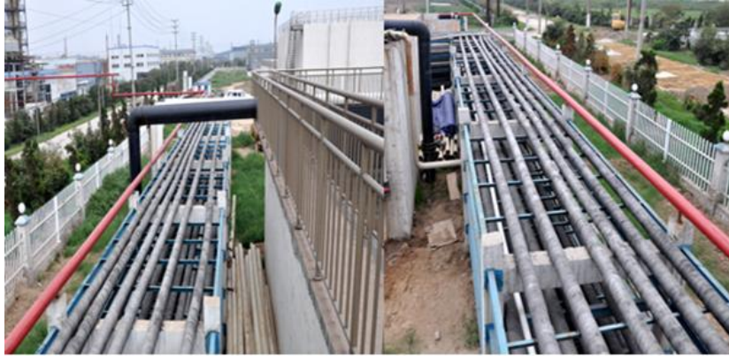
图 3-1 园区污水处理厂“一企一管”管廊图
