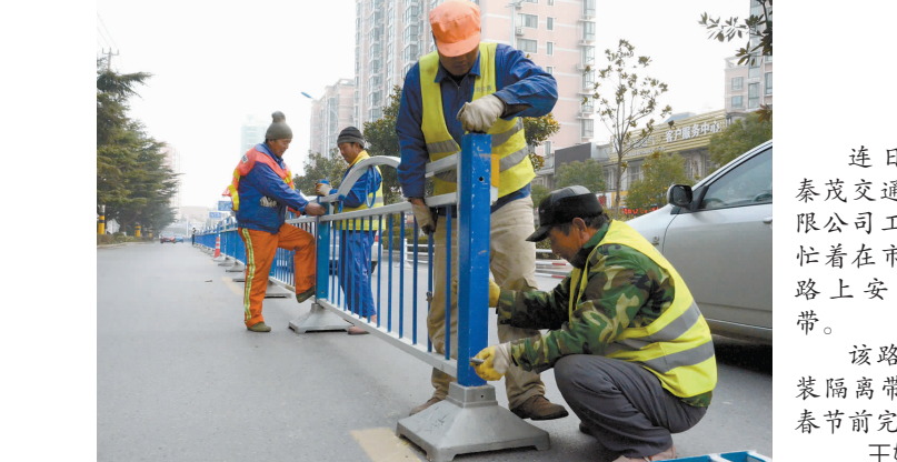
连日来,市泰茂交通设施有限公司工作人员忙着在市区民乐路上安装隔离带。该路段共安装隔离带500米,春节前完工。王婷婷摄
