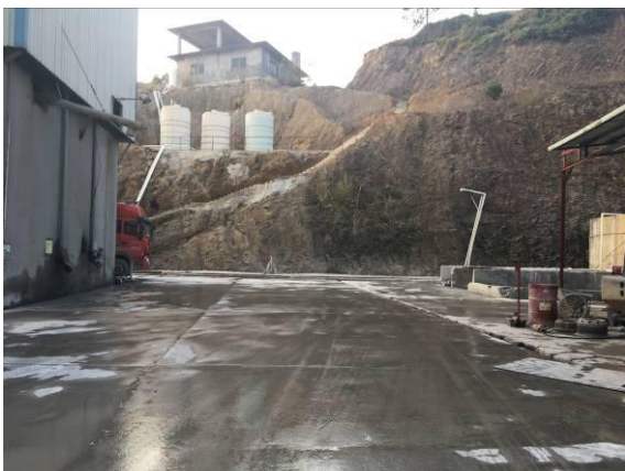
扩建项目用地现状
