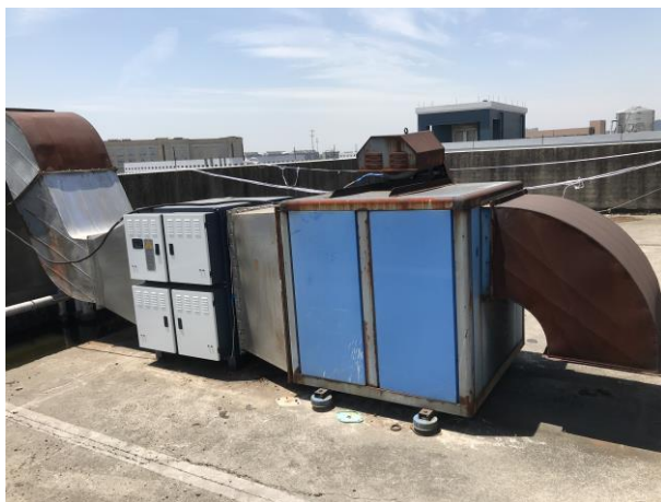
图 4-7 屋顶油烟净化装置照片
