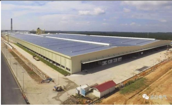
追日电气为信义玻璃马来西亚项目二期工程提供的 13 台有源电力滤波装置调试成功，顺利投运
