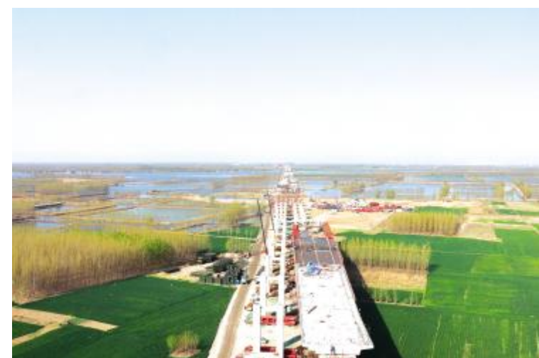
山东枣菏高速南四湖特大桥塔顶桥面铺装
