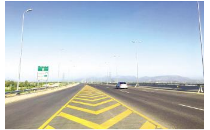
通车后的巴基斯坦E35高速公路
