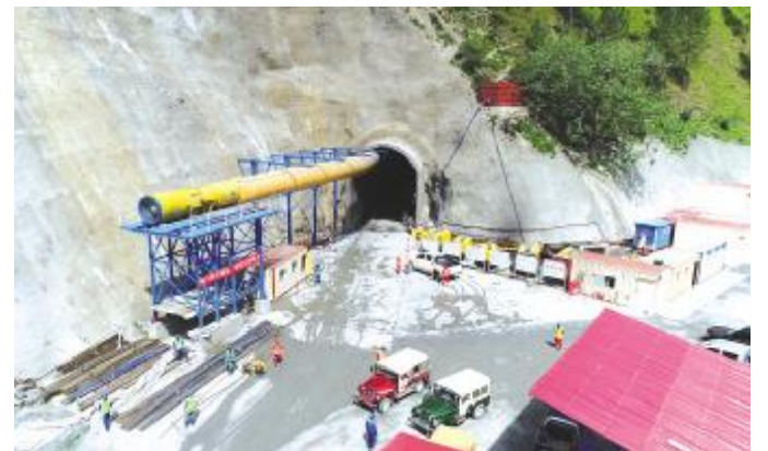
巴基斯坦SK项目交通洞施工现场
