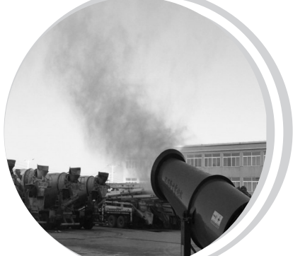
▲图为宿迁市工地雾炮除尘设施正在运转。
