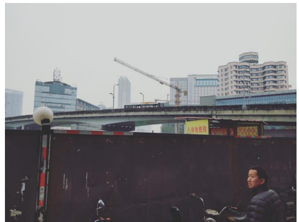
项目北侧的地铁施工区
