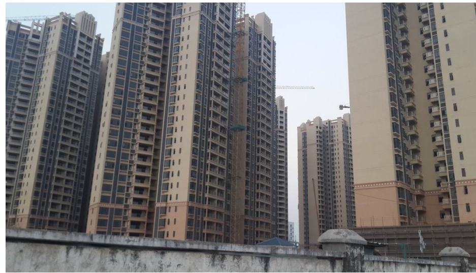
项目已建成部分
