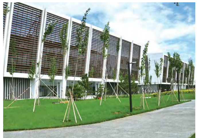
中国移动国际信息港一期数据中心
