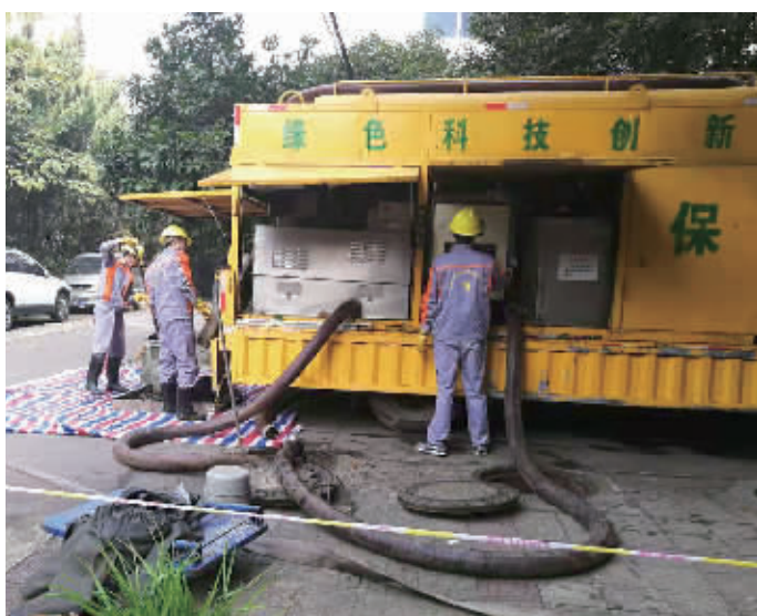
11月30日,长沙市天心区市政人员在新开铺社区进行粪污无害化处理。唐媛 摄
