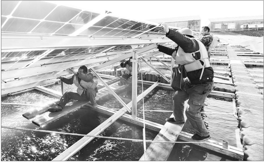
安徽省淮南市谢家集望峰岗镇刘岗塘淮南采煤塌陷区20MWp渔光互补光伏电站试验项目工程总装机容量为20MWp,预计2016年1月可并网发电,年均发电量可达2022万KWh,同时结合渔光互补一体化,将开展渔光互补示范项目,利用光伏板下水资源养殖水产,实现“上发电、下养殖”目标。 人民网图片网供图
