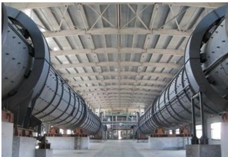
位于山东东营的世界上最大的成功运转的固体发酵装置
