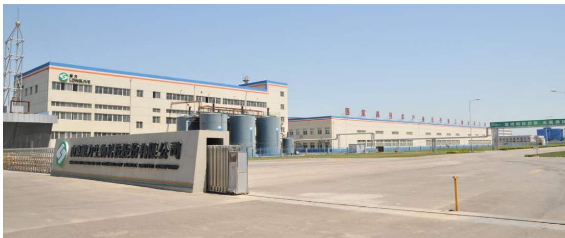
图 2 纤维素燃料乙醇工厂-山东龙力乙醇科技有限公司
