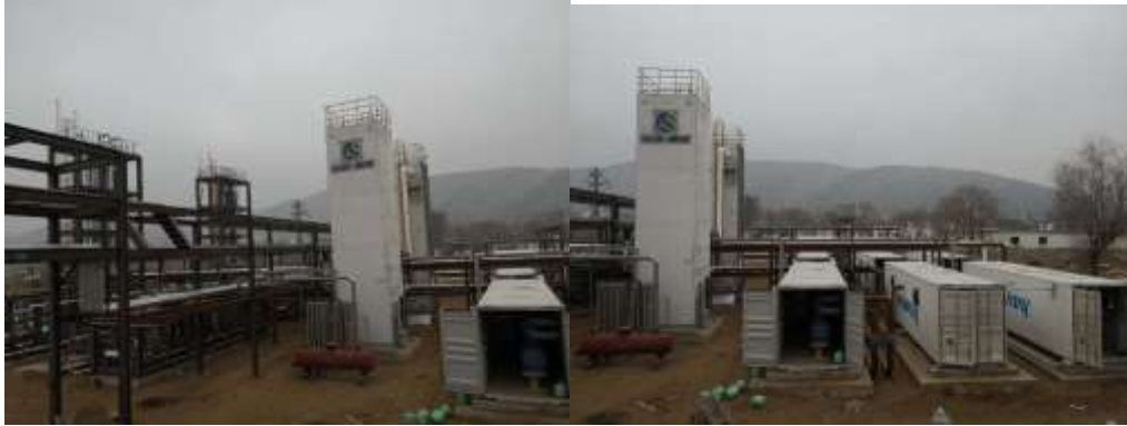
图 25. 新建设天液化项目现场
