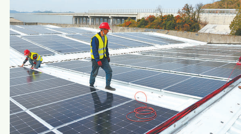
昨日，在五环市龙溪镇的浙江万得凯流设备科技股份有限公司厂房屋顶上，工人们正在安装光伏电站的电线。该公司充分利用1.2万平方米的闲置厂房屋顶资源，建成976千瓦分布式新能源光伏电站，节能减排，发挥经济环保的新效益。
