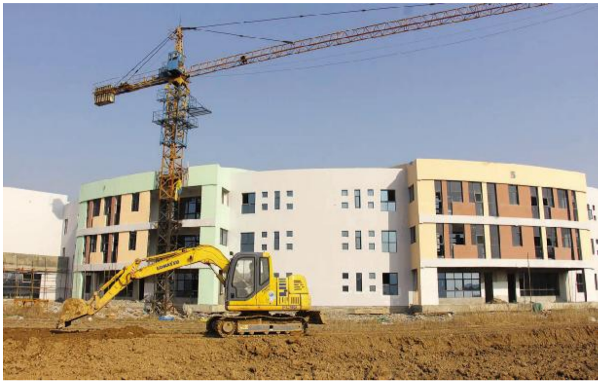
县幼儿园新园区工程总投资约5000万元,由上海同济大学规划设计院规划设计,占地50.9亩,总建筑面积约19387平方米。工程主体建筑包括教学楼4幢,办公楼、后勤服务楼、音体活动楼各一幢,目前工程主体建筑已竣工,等待相关部门验收。图为施工单位在新教学楼前平整土地。 记者 戴超 摄
