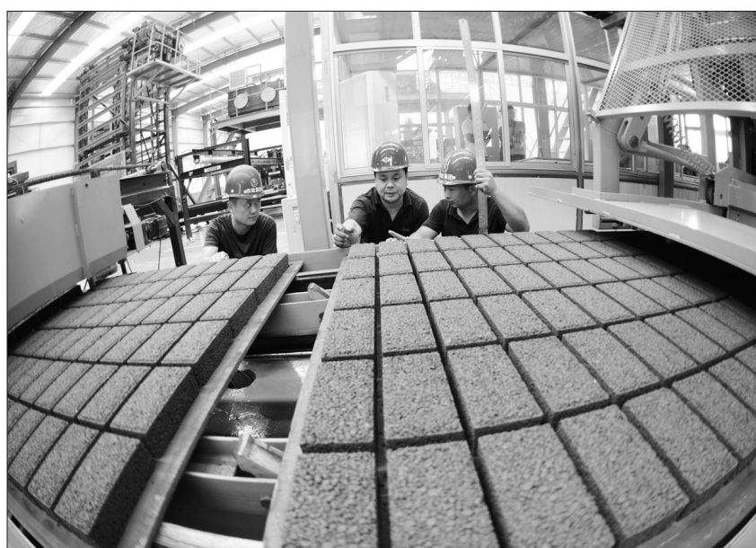
湖北襄阳市政工程总公司从美国进口的贝赛尔混凝土制品生产线近日正式投产运行。生产线以破碎筛分后的建筑垃圾、水泥为主要原料,掺加少量沙和粉煤灰生产标准生态砖或混凝土砌块。 人民图片网/安富斌摄
