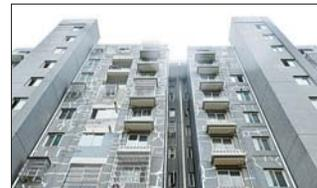
7月1日，江苏常州武进区宋剑湖三期安置小区被曝有质量问题。小区有8幢楼的外墙产生大面积裂缝，多户人家房屋渗水。施工方为了防渗漏，在外墙裂缝处涂了一条白色防水涂料，由于裂缝处多，白色涂料布满外墙，被戏称为“绷带楼”。（央广）
