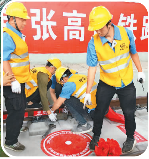
▲工人拧紧京张高铁轨道最后一根螺丝。本报记者 严冰摄
