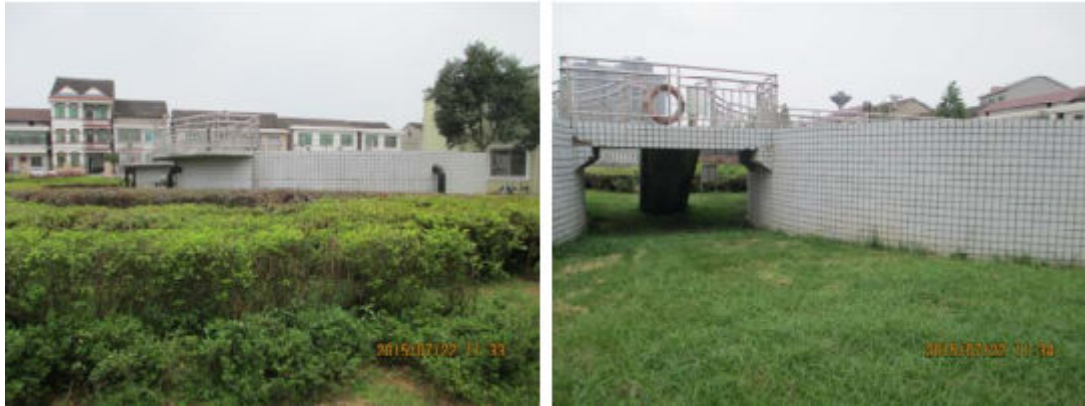
图 2-7 团洲污水处理厂贮泥池现状图
