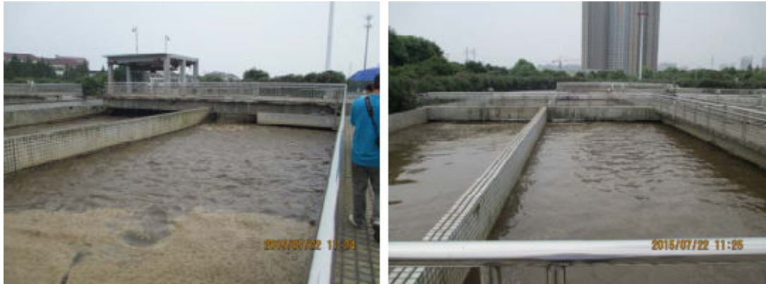
图 2-4 团洲污水处理厂氧化沟现状图
