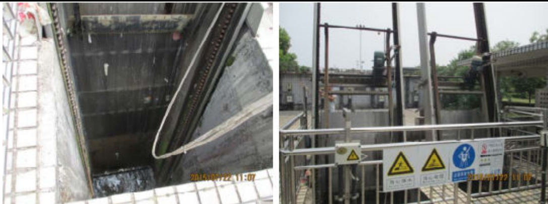
图 2-2 团洲污水处理厂粗格栅和提升泵房现状图
