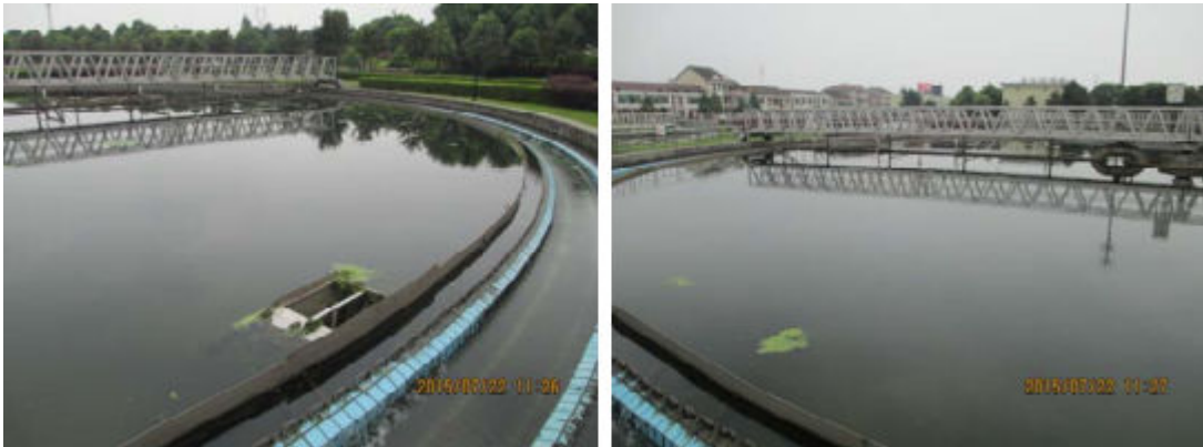
图 2-5 团洲污水处理厂二沉池现状图
