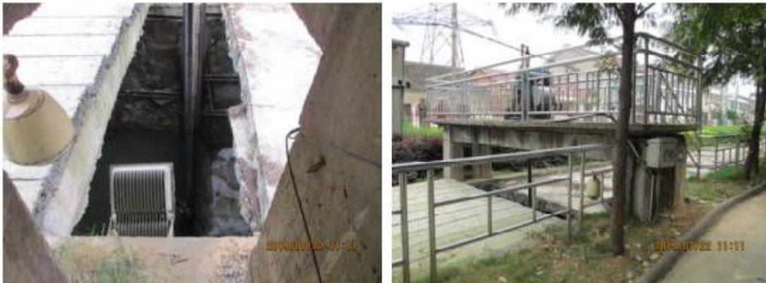
图 2-1 团洲污水处理厂进水涵闸现状
