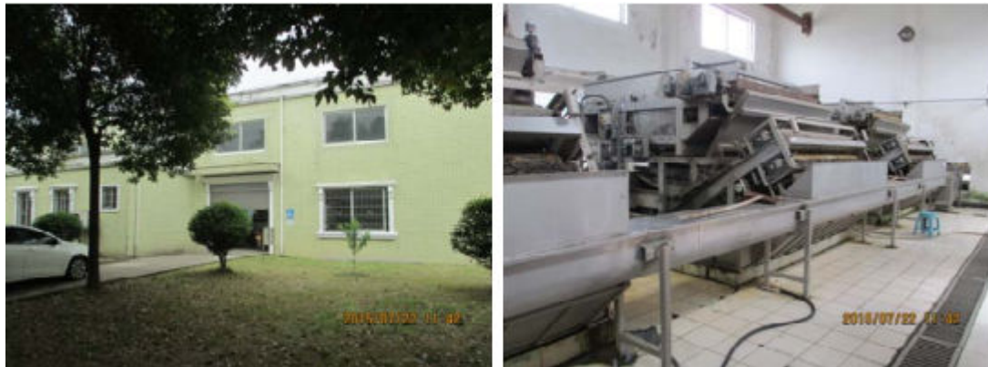
图 2-8 团洲污水处理厂污泥脱水间现状图
