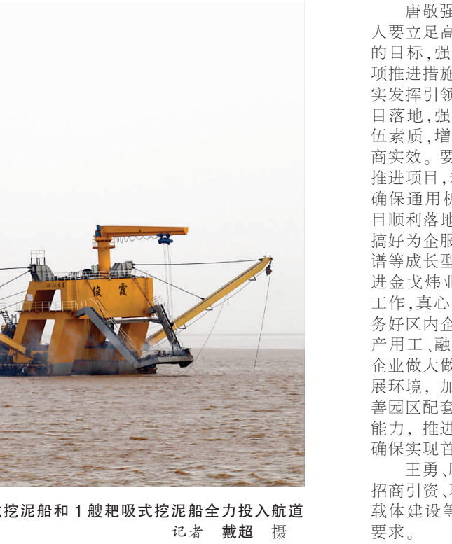
春节期间,射阳港航道二期疏浚工程正常施工,2艘大型绞吸式挖泥船和1艘耙吸式挖泥船全力投入航道疏浚,已完成疏浚土方量约300万方。图为航道疏浚施工场景。
