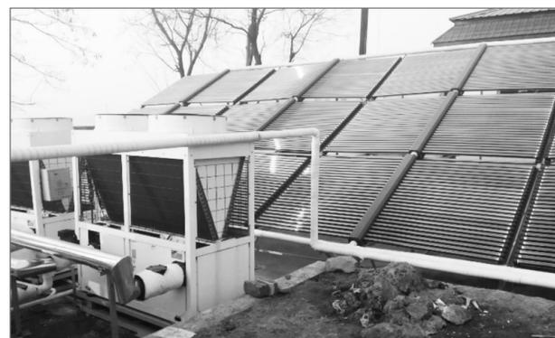
本报讯 河北省定州市积极探索农村冬季取暖新模式,在留早镇政府机关进行试点,投资80余万元实施了太阳能+空气能热泵供热改造示范项目,替代供暖燃煤锅炉。
