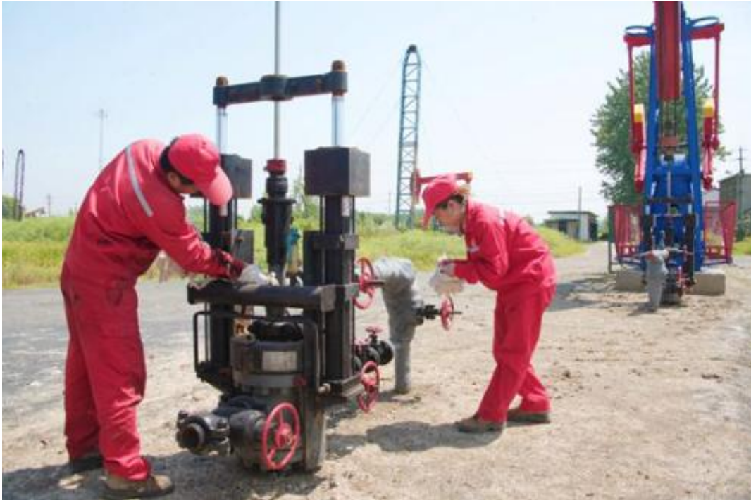
江苏油田采用井口套管气回收装置，年回收套管气天然气12万方。江苏油田宣传部范友林摄
