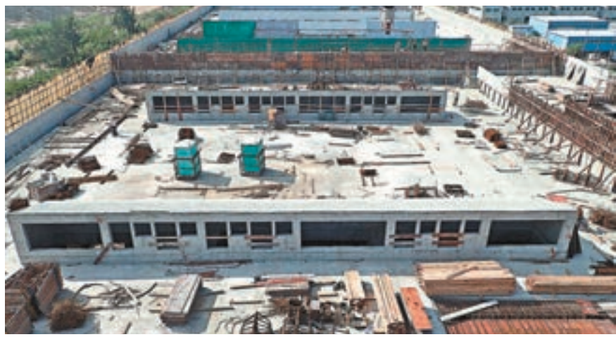
位處屯門的廢電器電子產品處理及回收設施,工程進展順利。
