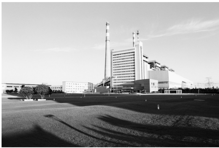
图为华润电力控股有限公司美丽的徐州公司厂区。
