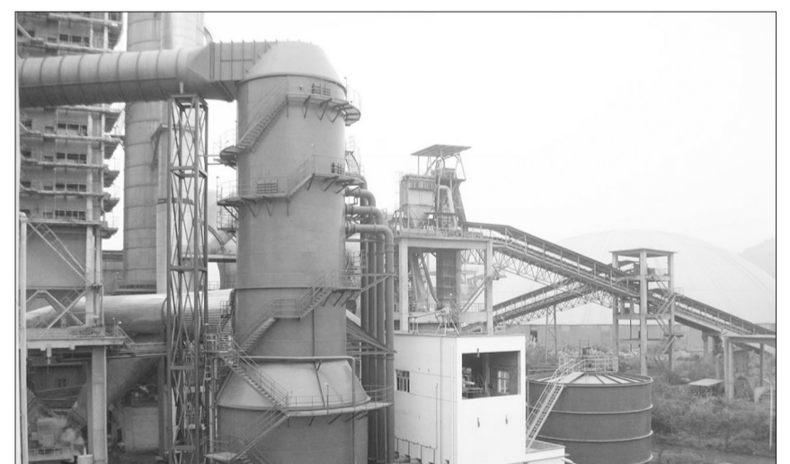
广东南大环保日产5000吨水泥窑脱硫项目。
