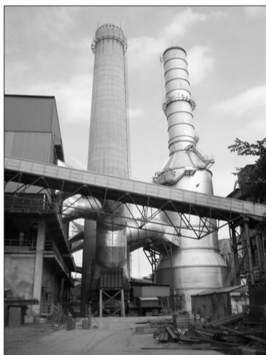
广东南大环保日产1万吨水泥窑脱硫项目。
