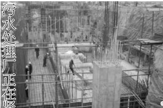
污水厂正在紧张建设中
